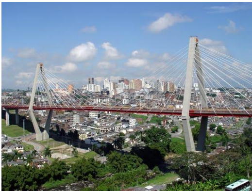
Imagen 1 Viaducto Cesar Gaviria
